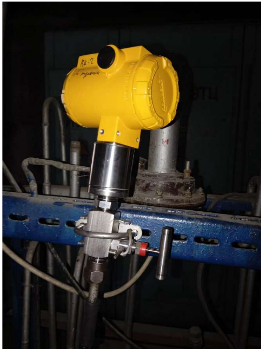
Преобразователь давления и разряжения АИР-20/-/М2-Н/ДИВ/305/АРС-2000/0,1/HS/(-700)-700 Па/(-125)-125 Па/ALW-PD/М/VM-1/0/15/0/Св/КЗ
