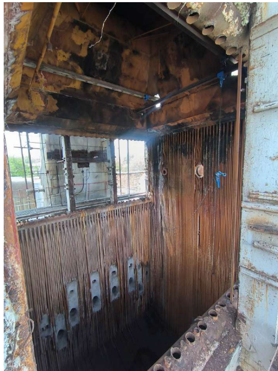
Водогрейный котел ПТВМ-100 ст.№3. КР котла с 100% заменой конвективных пакетов без коллекторов
