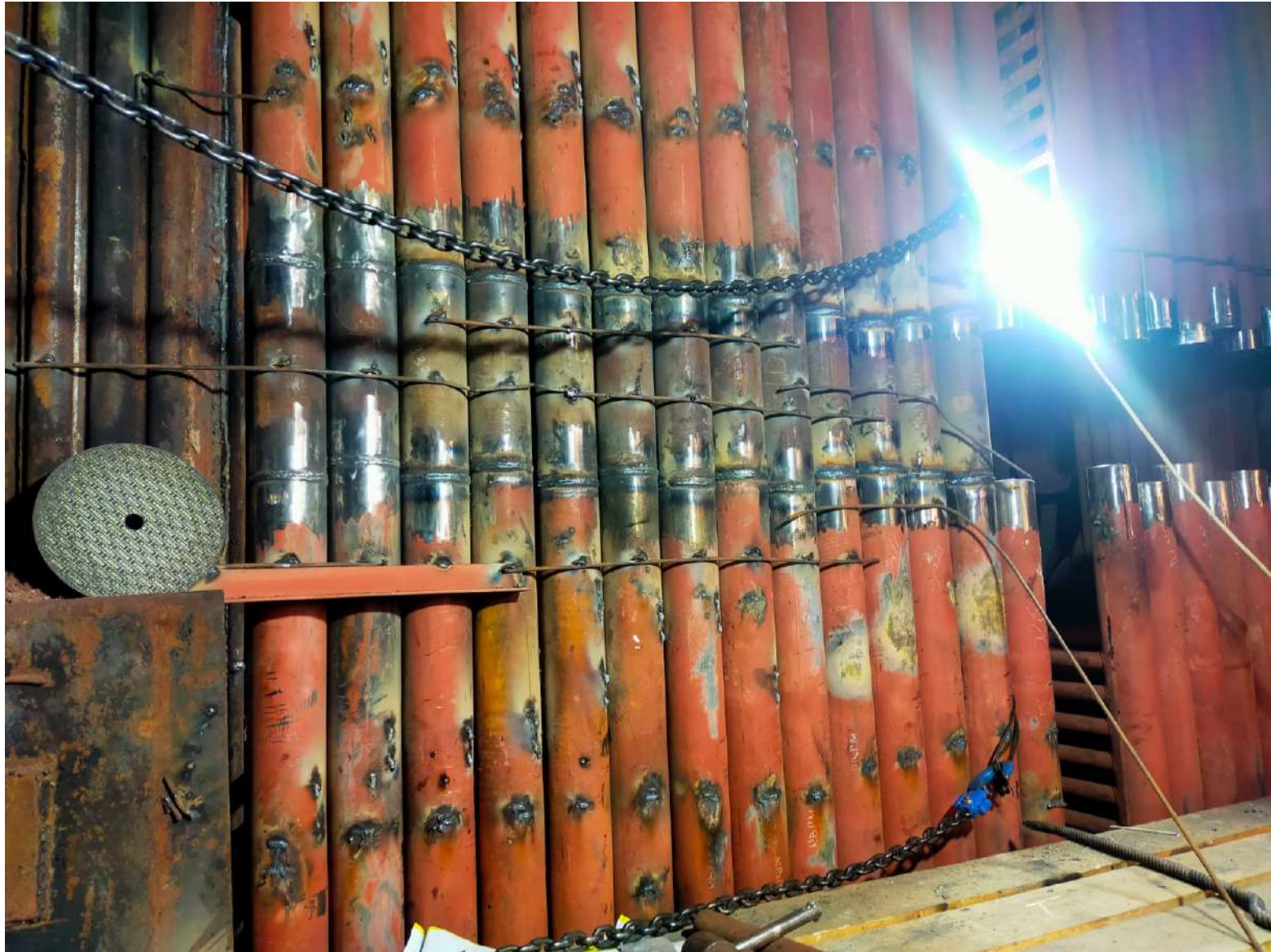
Водогрейный котел КВГМ-100 №4. Капитальный ремонт котла с 100% заменой конвективной шахты
